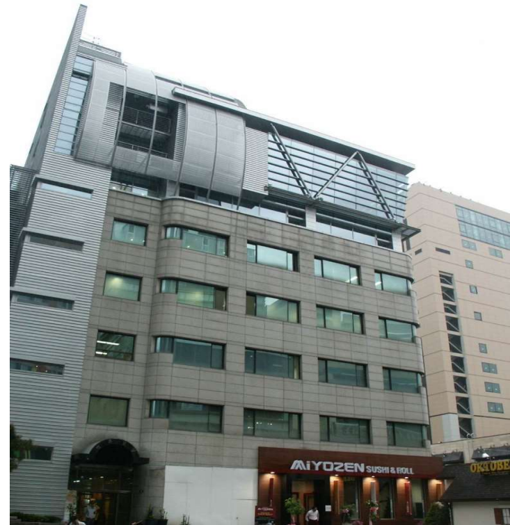
부분 5개층 + 부분 2개층 증축 (04년 증축공사 준공 후 13년 경과)
